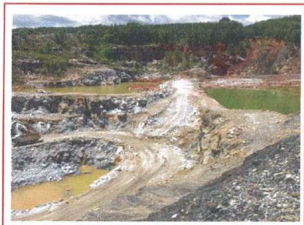
รูปที่ 4 บ่อดักตะกอนดินรองรับน้ำจากกระบวนการขุดแร่และน้ำจากชุมชนเหมือง
